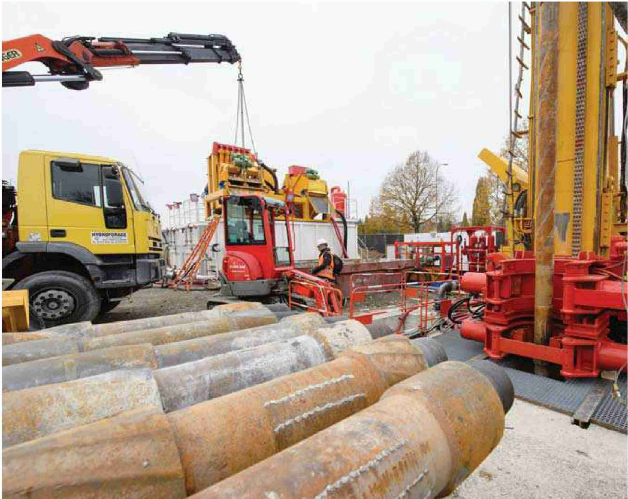
Sur le chantier de Satigny, la foreuse est prête à creuser le premier puits. KEYSTONE
